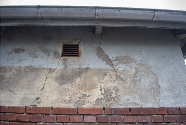
Det målade partiet högst upp på fasaden har tidigare haft en gulare nyans.
