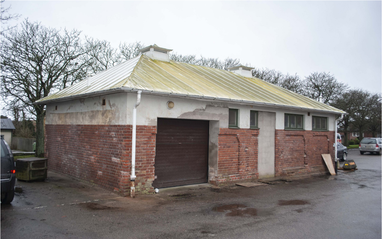
Det lilla huset sett från sydost. På östra långsidan finns en senare upptagen garageport samt en igensatt dörr. Även denna dörr kan dock vara senare tillkommen då den inte är anpassad till tegelfasadens fältindelning.
