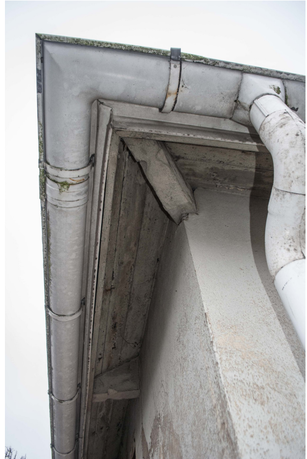
Takpräntet är byggt av vitmålade brädor med fint utformade taktassar. Hängränorna bygger ut takfoten betydligt och ger huset andra proportioner.
