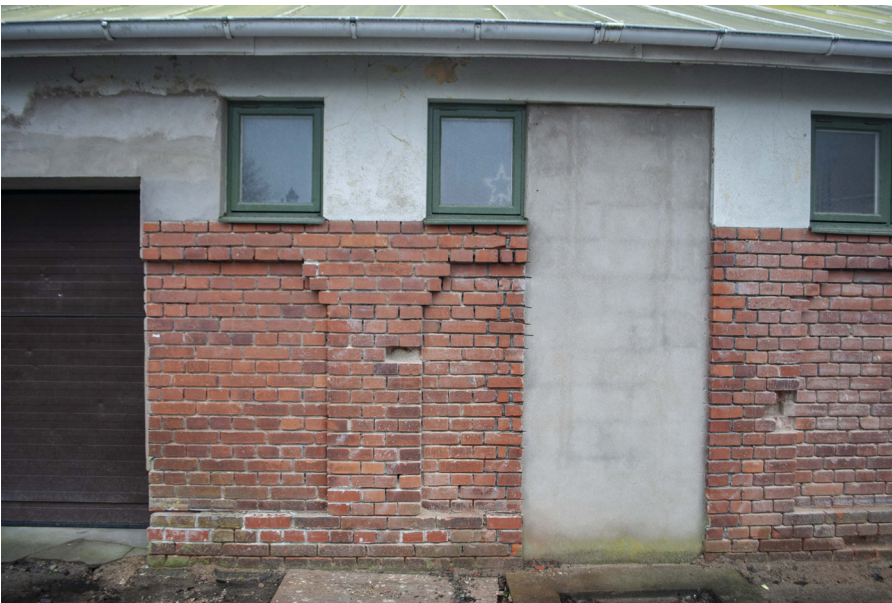
Eftersom tegelmuren mönstermurats med indragna fält borde originalplaceringen av dörrar ta hänsyn till detta. Garageporten och den igenmurade dörröppningen är därför av största sannolikhet senare tillkomna.
