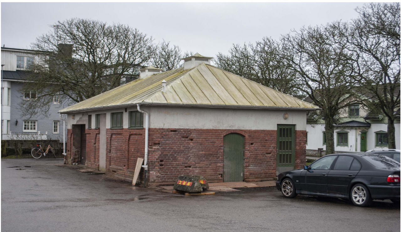
Det lilla huset sett från nordöst. Plåttaket är från andra delen av 1900-talet i en ljus bandplåt. Formen och placeringen av de båda dekorativa ventilhuvarna har troligen funnits med sen husets byggnadstid.
