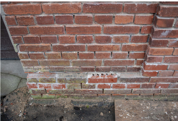
En del tegelstenar har bytts. Det är dock mycket olämpligt med hålsten såväl av estetisk som funktionell aspekt då det samlas fukt i hålen som kan orsaka frostsprängning.
