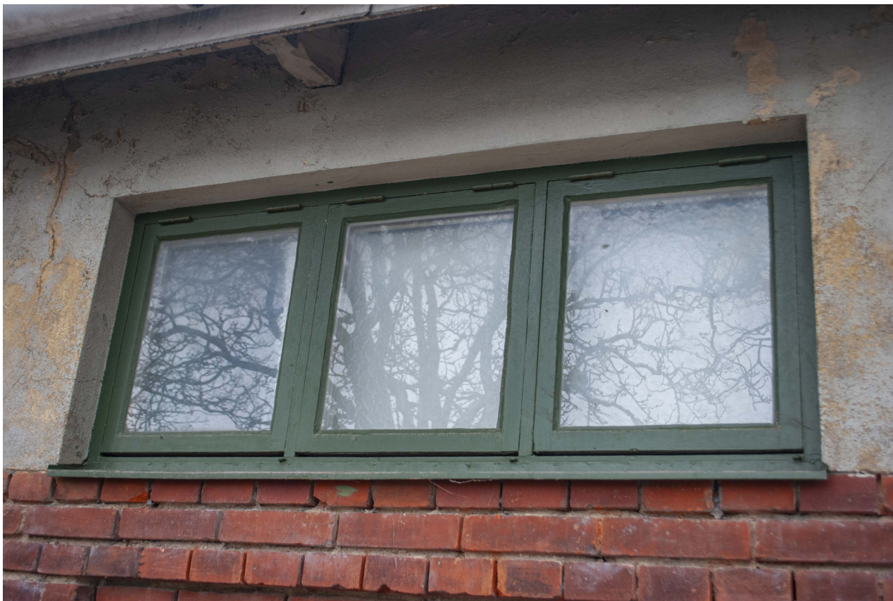
Fönstren kan vara original och ser ut att vara i gott skick. Gångjärnen hänger i ovankant vilket är en något ovanlig konstruktion.
